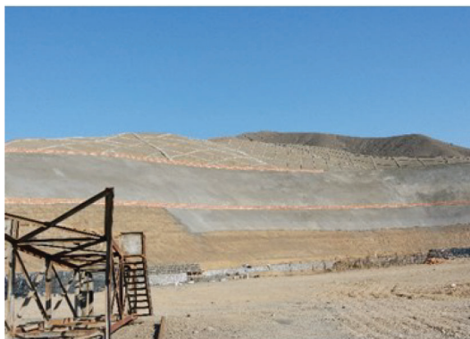
斜坡防護工程
